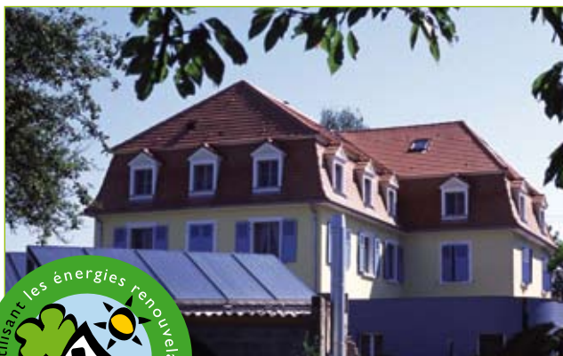
Un panneau vert à l'entrée de l'hôtel souligne l'engagement de l'établissement en faveur des énergies renouvelables
