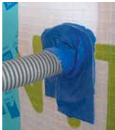
La traversée d'une membrane par une gaine électrique ou un conduit doit être étanchée pour assurer la continuité du plan d'étanchéité à l'air.
