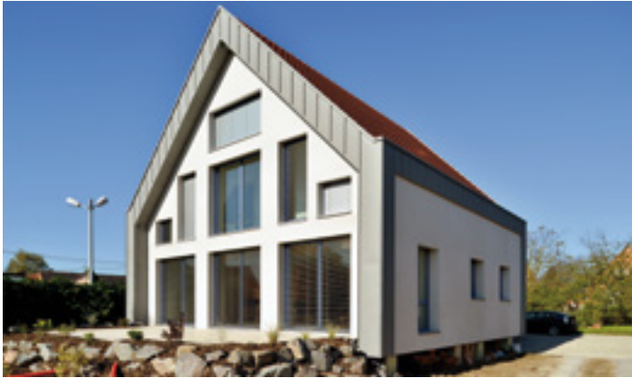
Vue sur les façades Sud et Est
