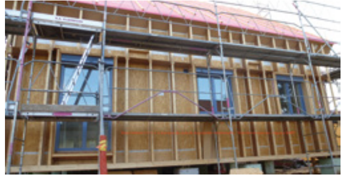
Façade avec l'ossature bois en «I»
