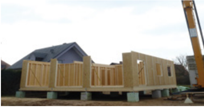
Mise en œuvre de l'ossature bois
