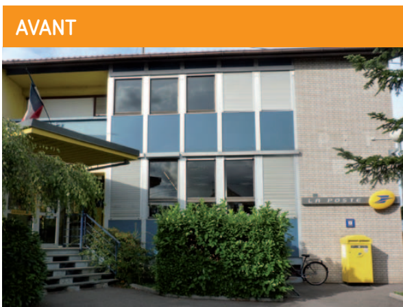
Poste située 17 rue de Lyon à Fegersheim
